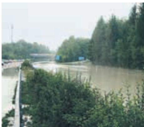
Die Autobahn A6 bei Rubigen im August 2005. L'autoroute A6 au niveau de Rubigen en août 2005.
